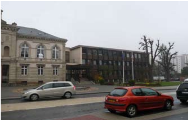
Photos avant travaux
